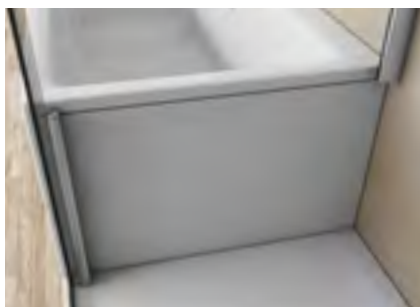
■ A rövidített oldalfal kádhoz való csatlakoztatásának részletei
