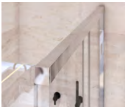
■ Az ajtóprofil és az oldalfal csatlakozásának kialakítása
